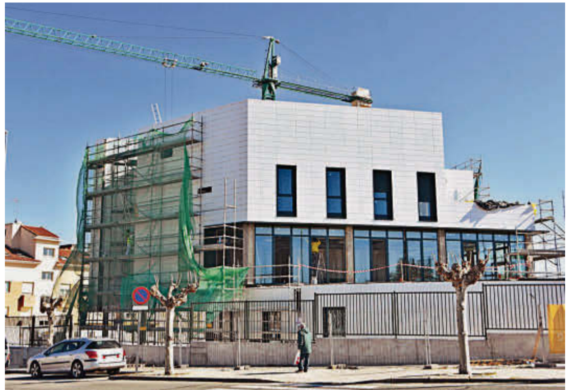
Un hombre mira a los operarios en el interior del nuevo cuartel de la Guardia Civil en Santa Marta. EÑE
